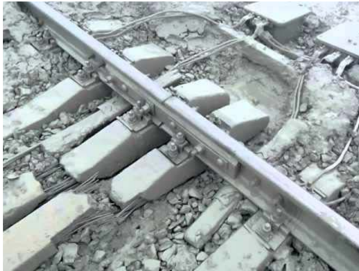
Рис. 1. Пример выплеска балластной призмы
